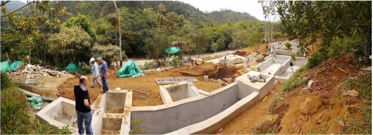
Foto Vallecaucana de Aguas / Obra Ecoparque Pance - Cali, Valle del Cauca
